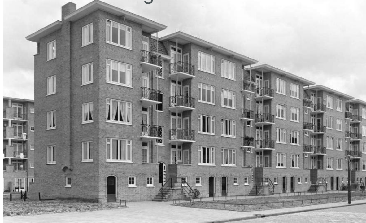
metselwerk met gaten
