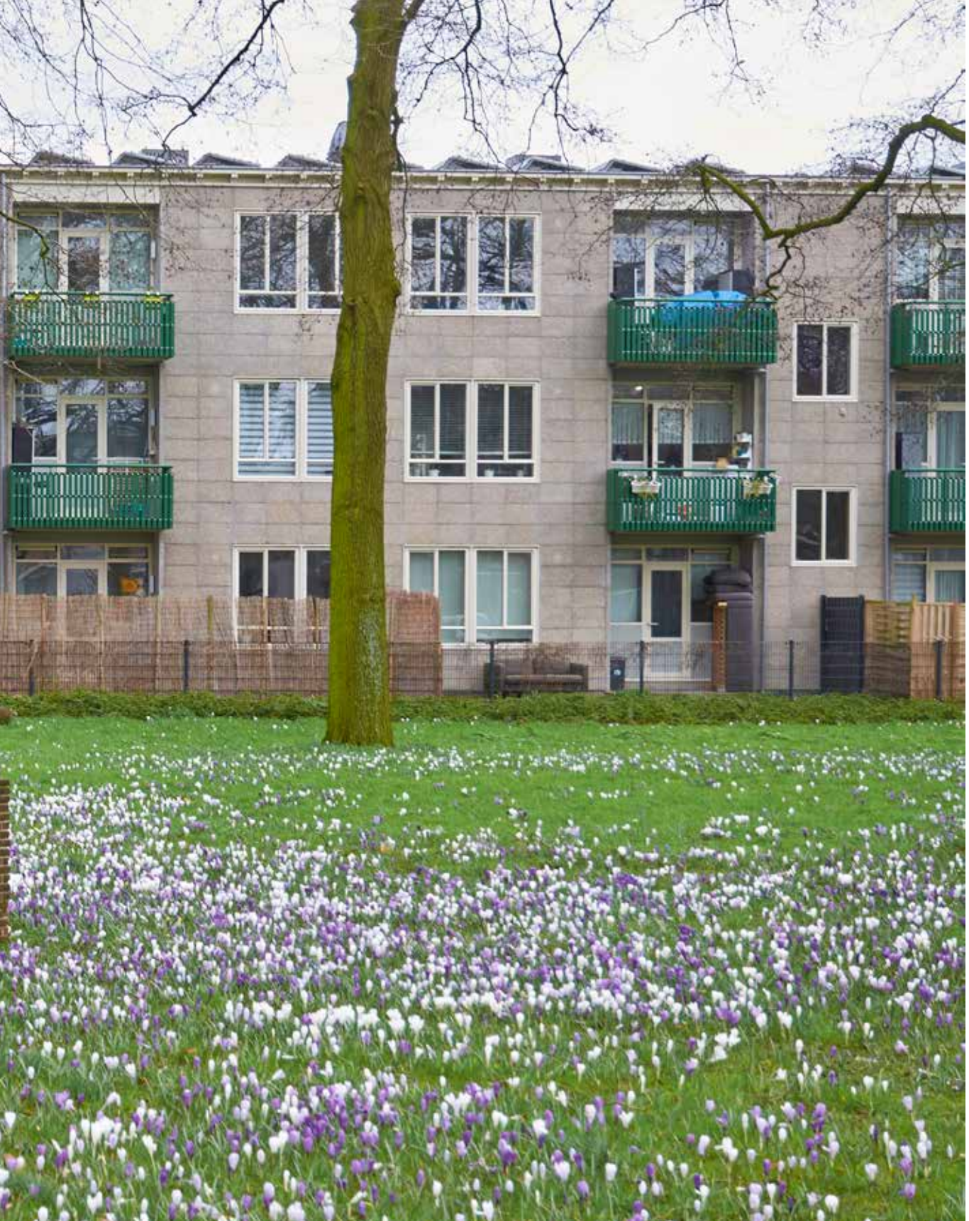
Slotermeer, Johannes Poststraat en Postmahof: hoogwaardige renovatie van zeven van de veertien Airey-blokken in beschermd stadsgezicht 'Van Eesterenmuseum'. Isolatie achter de originele gevelbeplating, isolatieglas en zonnepanelen op de platte daken. (Ontwerp: Hooyshuur Architecten)
