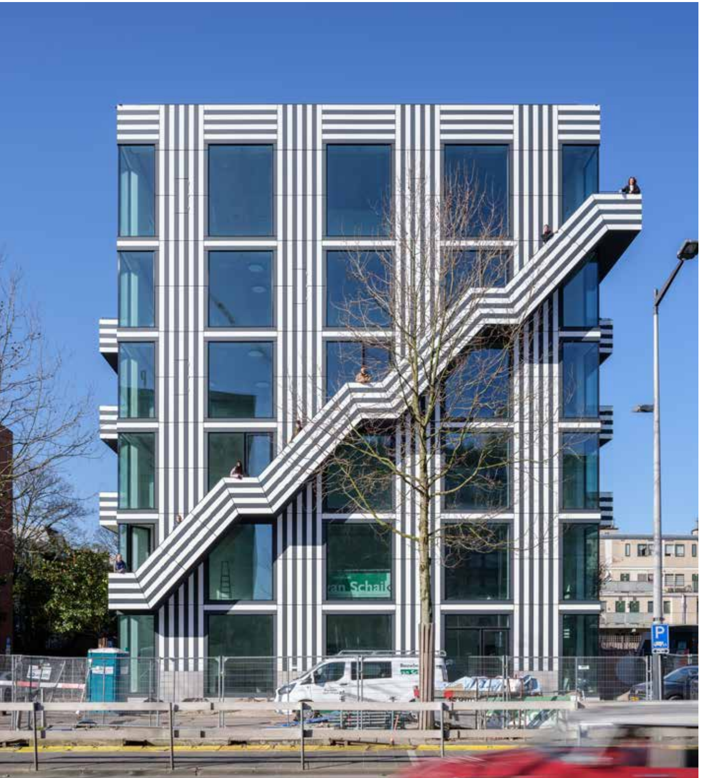
Wibastraat , gebouw Thonik. Eigentijdse invulling met creatief gebruik van volkernplaatmateriaal. (Ontwerp: Thomas Widdershoven - Thonik i.s.m. Arjan van Ruyven - MMX architecten)
