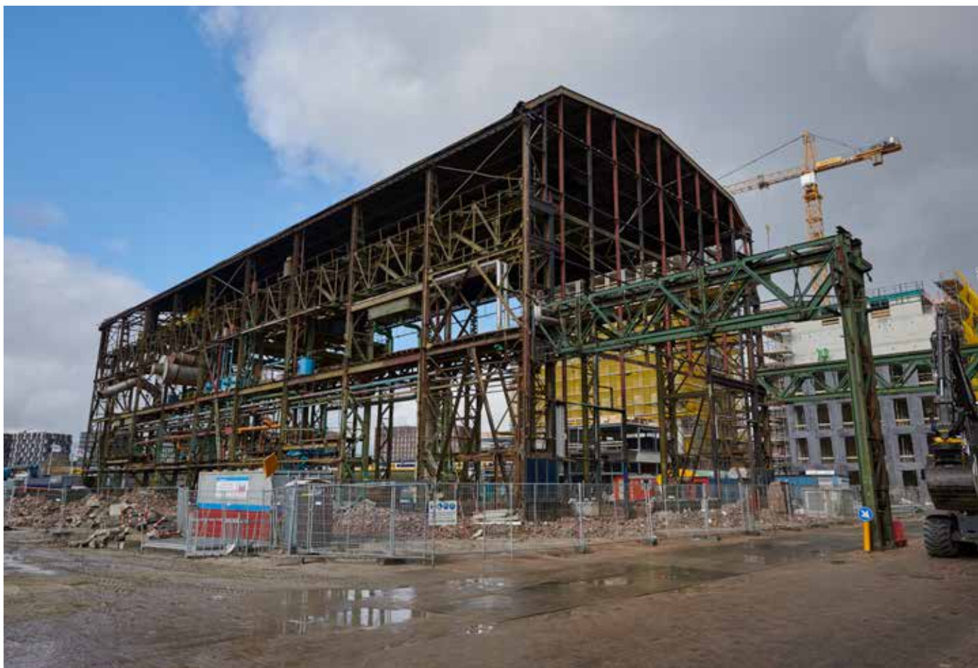
Oostenburg , nieuwe stedelijke wand met verwijzingen naar het industriële karakter van het eiland en geraamte van de Werkspoorhal uit 1928. De bedrijfshal is het oudste onderdeel van de Werkspoor Motorenfabriek en zal met een openbare bestemming in de nieuwbouw worden opgenomen. (Ontwerp nieuwbouw: Paul de Ruiter Architects, Bastiaan Jongerius Architecten, Ronald Janssen Architecten)
