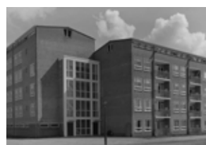
METSELWERK MET GATEN EN ORNAMENTEN
